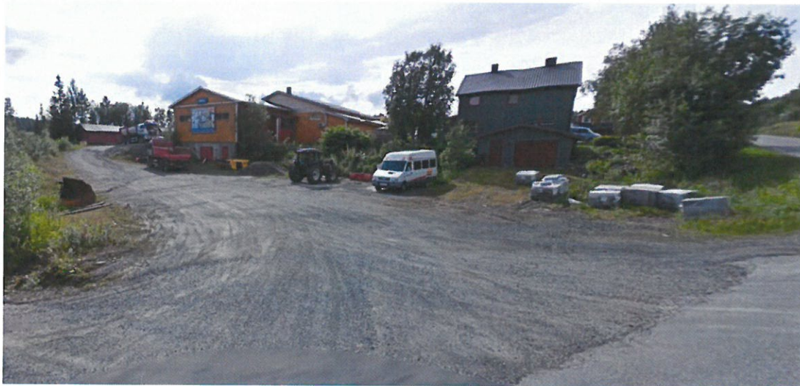
Området sett fra fv. 7016 og vestover. Bolighus til høyre og næringsbygg til venstre.
