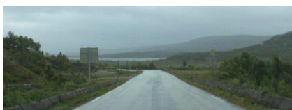
Dagens situasjon av plass etter tunnelen
