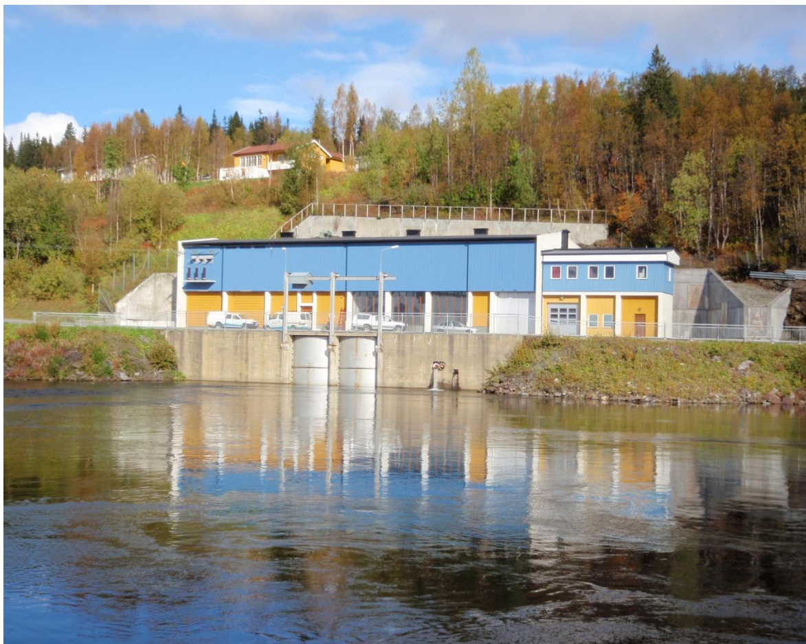
Bilde: Røyrvikfoss kraftstasjon
