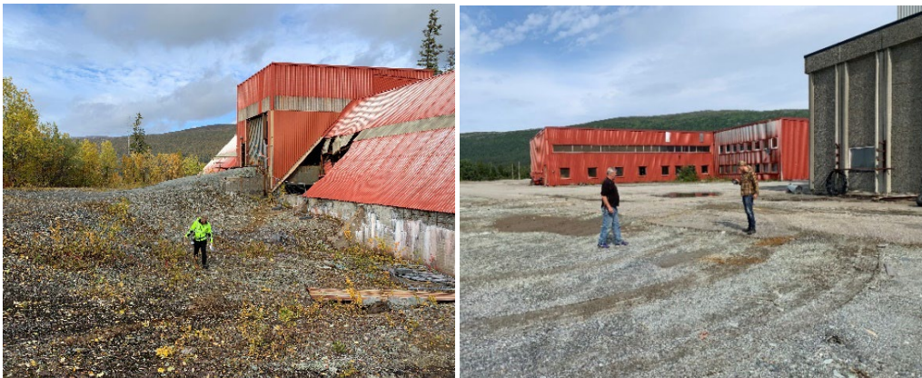
Figur 2-7: Bilde til venstre: Råmalmsilo. Bilde til høyre: Verksted (rød bygning). Området hvor det står to personer er stedet hvor konsentratsiloene var plassert, og hvor konsentrat ble tappet over til lastebiler.
