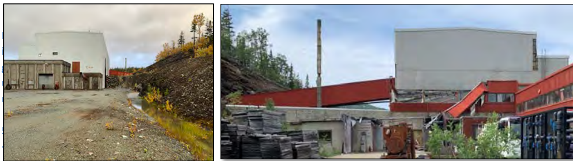
Figur 5-5 Bilder av eksisterende industribygg for oppredningsverket. Bru fra silo i fjellet vises på bildet til høyre.
